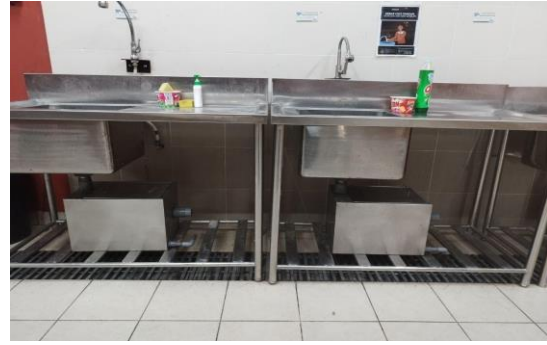
Pemasangan perangkap minyak (grease trap) di sinki bengkel makanan
